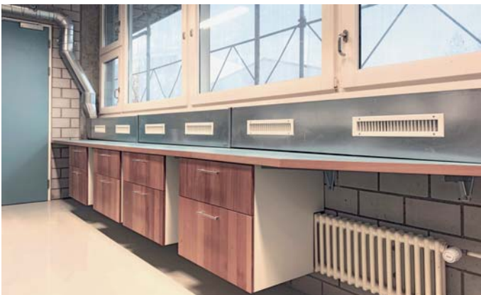
Farbmischraum mit Absaugsystem auf der Arbeitsfläche.
