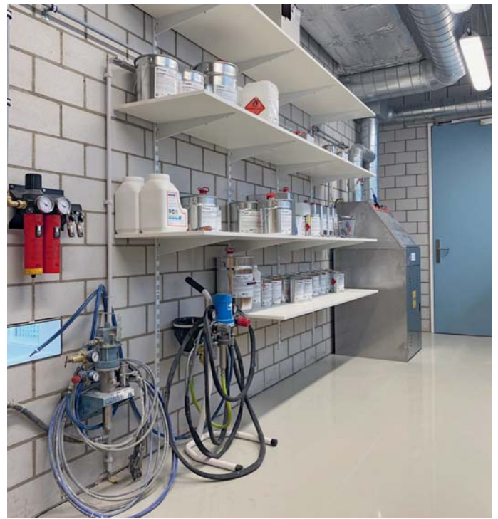
Farbmischraum mit leitfähigem Fussboden.
